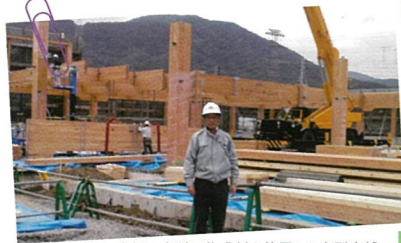
唐松の大断面集成材を使用した大型店舗
