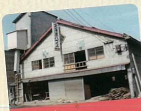
昭和31年 建築用パネル生産工場新設。
