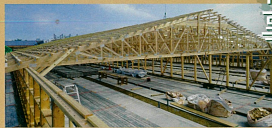
間口25m、奥行110mと大規模な建物のため、精度管理が困難です。建て方工事中に何度も寸法を当たり、調整することによって建物全体の精度を上げています。
