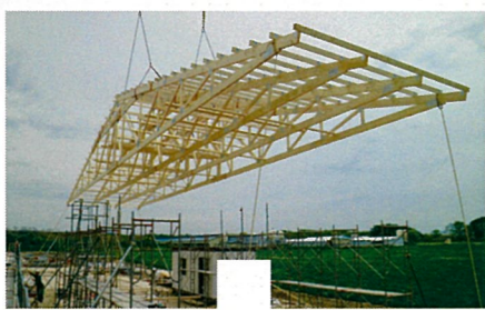
通常トラスは1枚1枚建てますが、当社の施工では、地面で地組して接合する方法で建て方をし、施工効率と建て方精度の向上を図っています。
