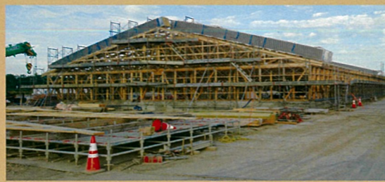
間口25m、奥行110mと大規模な建物のため、精度管理が困難です。建て方工事中に何度も寸法を当たり、調整することによって建物全体の精度を上げています。
