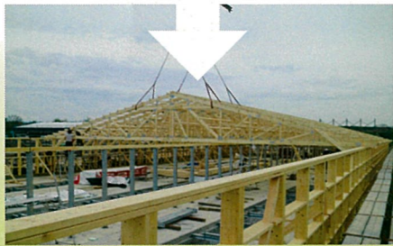
通常トラスは1枚1枚建てますが、当社の施工では、地面で地組して接合する方法で建て方をし、施工効率と建て方精度の向上を図っています。
